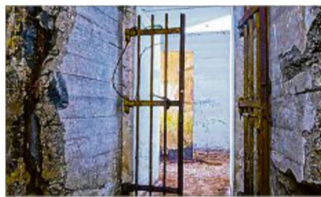
Die Vorschleuse des zweiten Zugangs (umbaut beim Bau des Barmenia-Hauses).
