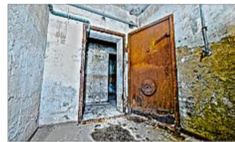
Die Schleuse des ersten Eingangs mit einer dicken Stahltüre.
