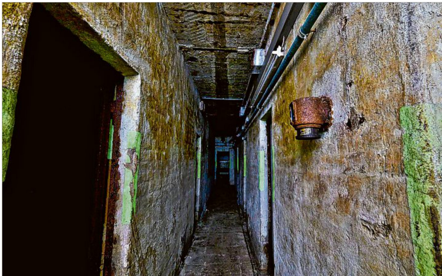
Ein Blick in den Flur des Tiefbunkers unter der Hindenburgstraße (mit Resten der Leuchtfarbe an den Wänden): Seine Zukunft wird im Zusammenhang mit der Neugliederung der Gegend um die Bahnhofsstraße diskutiert. Fotos: Markus Jung
