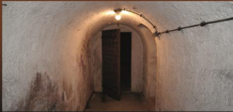
Keller unter dem alten Roten Haus in der Grabenstraße aus dem Jahr 1700
