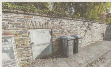
Bunkerzugang in der Oberstadt: Ein Gewölbe liegt hinter der Tür, eines hinter dem Fenster rechts.
