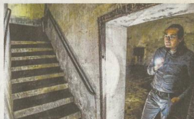
Markus Jung im Tiefbunker in der Oberstadt: Ein altes Tonnengewölbe aus dem 16. Jahrhundert. FOTOS (A): HENDRIK SCHULZ
